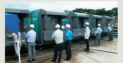
自動起動並列運転試験風景
