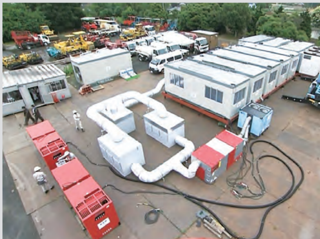
福島プロジェクトの施設・機械類
