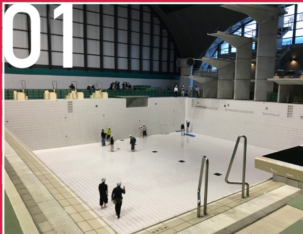
01 パンパシフィック水泳選手権の会場となった東京辰巳国際水泳場。ダイビングプールの水を抜き、底面の清掃を行う 02 タイルの部分にビニール、底面を板で覆う。そのうえにパイプで骨組みを組んでいく 03 目に見えない地下の部分でしっかり基礎を作ることで、8mの高さのスタンド席の強度を保つことができる 04 地上においても階段上に骨組みを組んでいき、両端に欄をつけ、スタンド席として形になっていく 05 背もたれのある椅子を設置し完成。最上段上の飛び込み台はそのまま 06 お客さまやメディアが着席し、パンパシフィック水泳選手権を観戦
