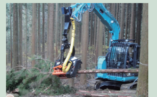
枝払い作業中の林業機械ハーベスタ
