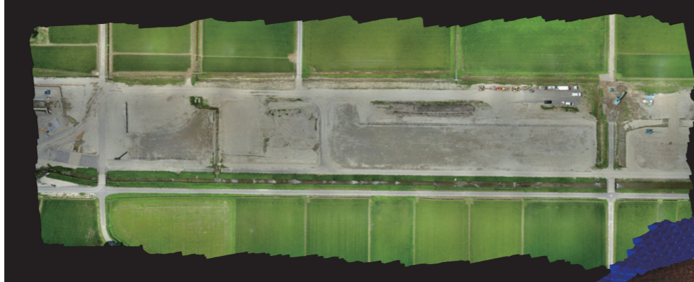
ドローンで空から撮影した複数枚の写真を組み合わせて、傾きや歪みを排して正確な位置と大きさに表示されるように補正した「写真画像」
