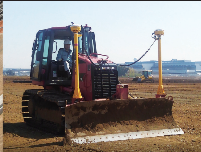
高精度な整形作業中のMCブルドーザ (GNSS)
