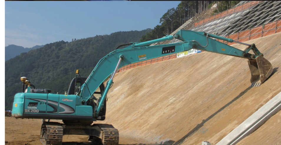
法面整形中のMGバックホー (GNSS)
