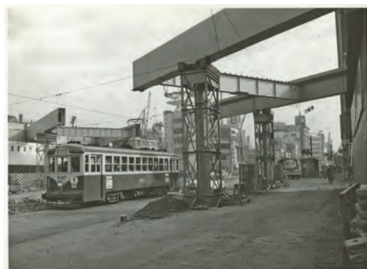
1958(昭和33)年頃の高速道路建設工事。晴海通り数寄屋橋付近 写真提供:中央区立京橋図書館
