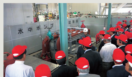
水中ポンプ設備スペース
