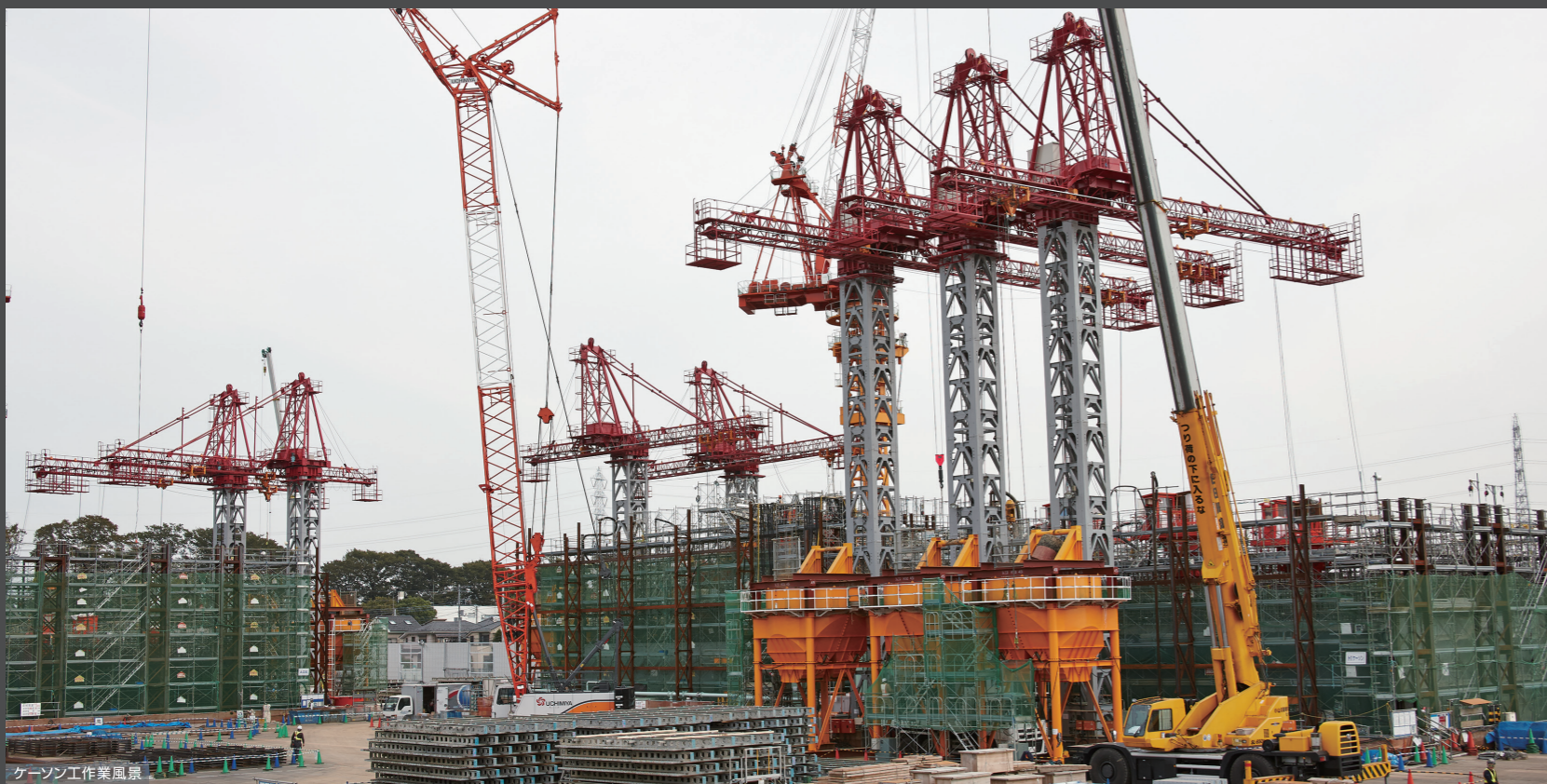
ケーソン作業風景
