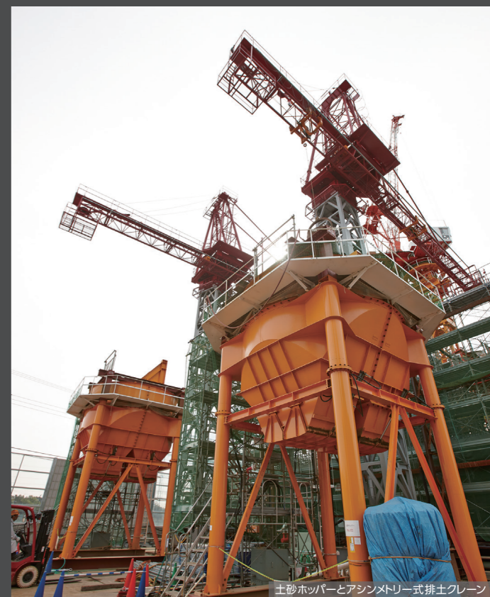
土砂ホッパーとアシンメトリー式排土クレーン
