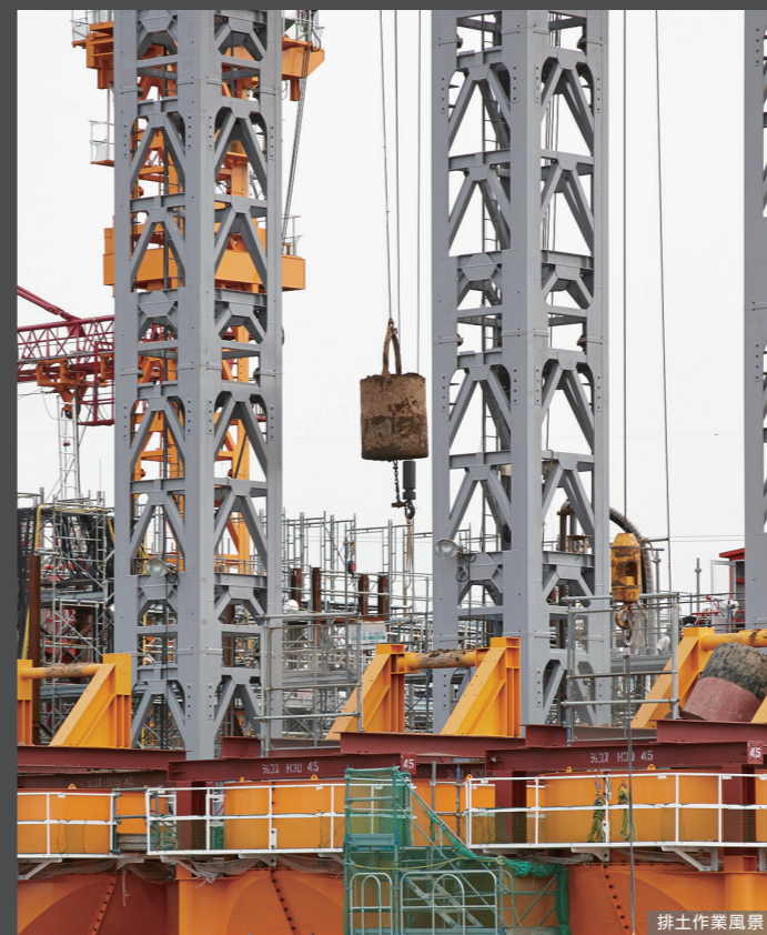
排土作業風景
