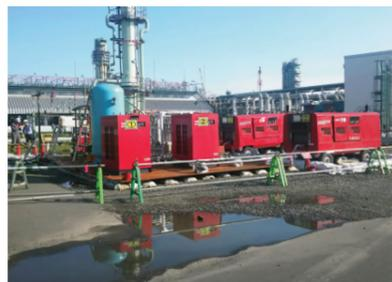
製油所に設置された代替コンプレッサシステム。停電時も、陸上出荷場のローリーへの燃料供給を止めずに済むようになった。
