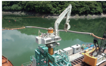
天ヶ瀬ダム再開発トンネル放流設備流入部建設工事風景
