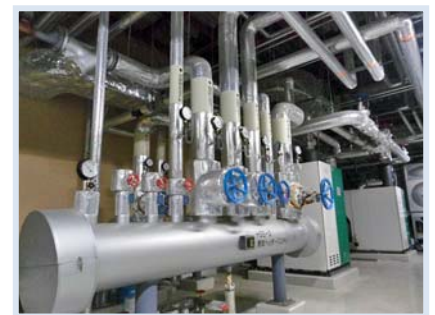
▲工場内ボイラー室
