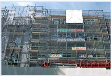
▲ビル建築現場
