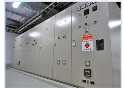
▲工場内電気室
