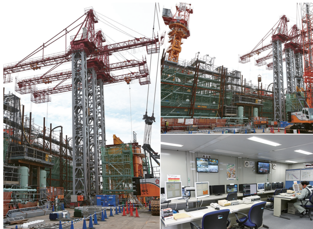
*ニューマチックケーソン工法：あらかじめケーソン下部に作業室を設け、その中に圧縮空気を送り込んで気圧の高い状態にし、この圧気によって水や泥の流入を防止して掘削作業を行い、所定の深さまでケーソンを沈設する工法。
