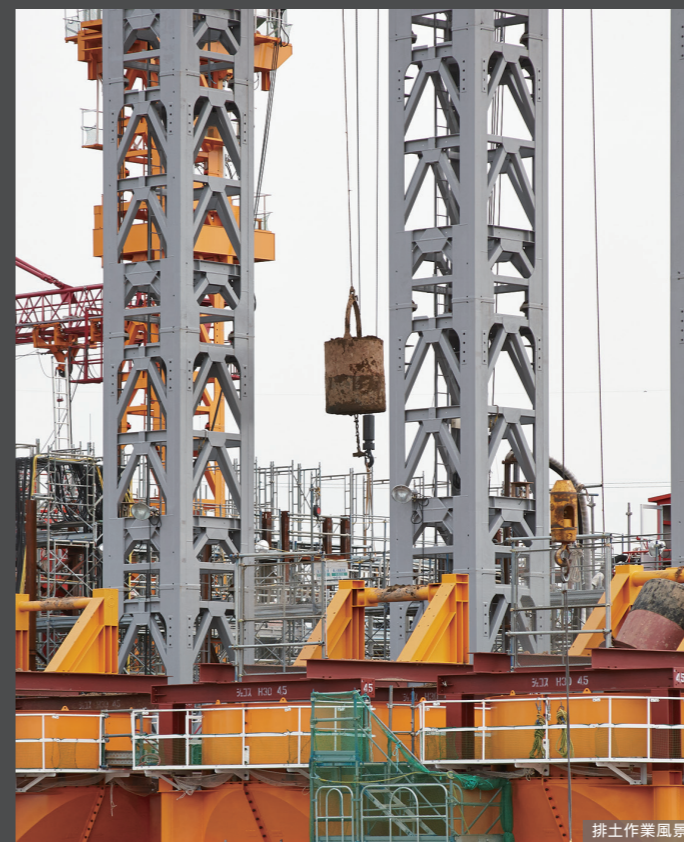
排土作業風景
