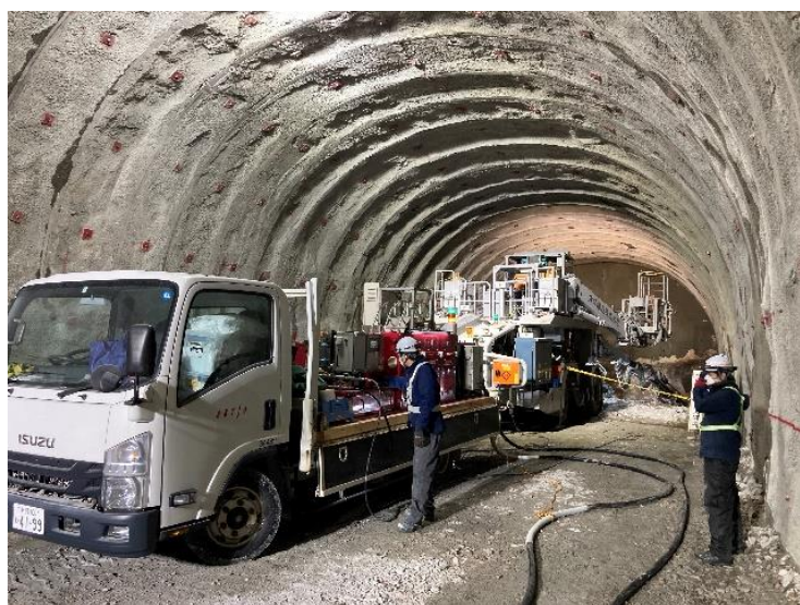
装薬時の機械配置
