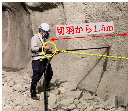
装薬作業状況
