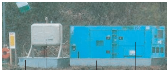
燃料タンク用防油堤 外部燃料タンク 発電機用防油堤 発電機本体
