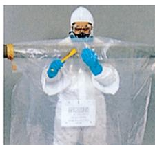
開口部に配管等を包み込み密閉、外側より手を差し入れ安全に効率的に除去作業が行えるポリエチレンシート製部分隔離養生材。作業部位に合わせ、7つのタイプからお選び頂けます。ニトリル手袋付き。
