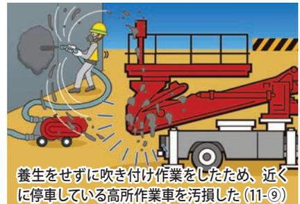
養生をせずに吹き付け作業をしたため、近くに停車している高所作業車を汚損した (11-⑨)
