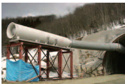
・トンネル現場設置例
