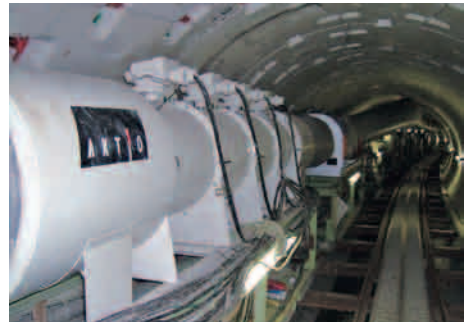
・坑内設置例
