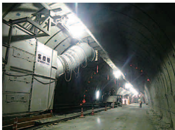
現場設置例(電気式集塵機設置例)
