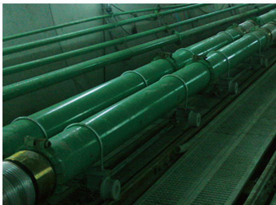
・泥水輸送管+一軸二輪台車
