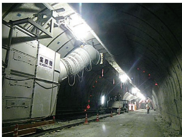
現場設置例(電気式集塵機設置例)
