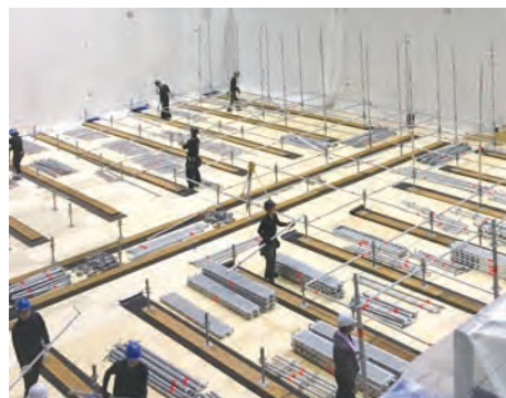
仮設スタンド組上げ作業風景
