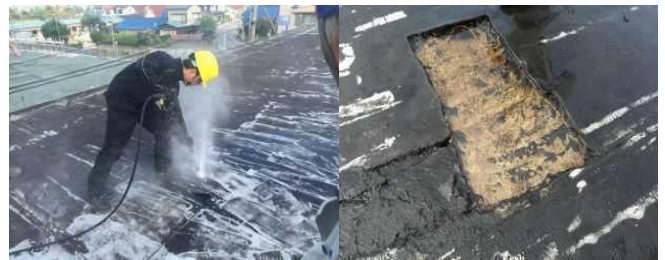
防水シートの剥離作業にも！
