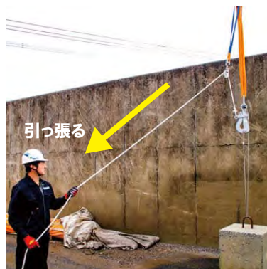
ラフタークレーンの場合、主巻・補巻に取り付ければ、クレーン操作で玉外しが可能
