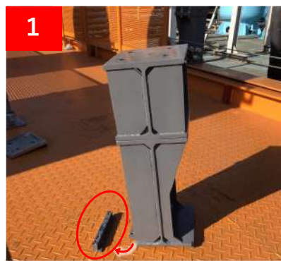
①かさ上げブラケットから下部押さえ金物を分解
