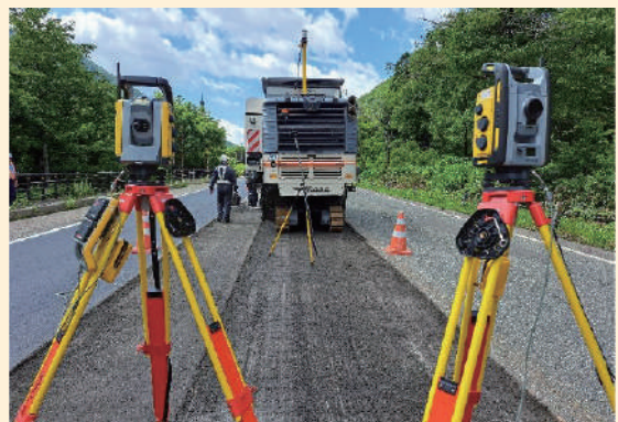
左：重機の位置情報を観測／右：切削後の深さ（高さ）を観測
