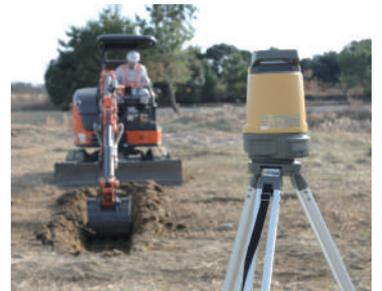
運転席のモニターでは、設計データ上のバックホウの位置、ブームの動きをリアルタイムに確認が行えます。設計面に合わせた施工が可能です！
