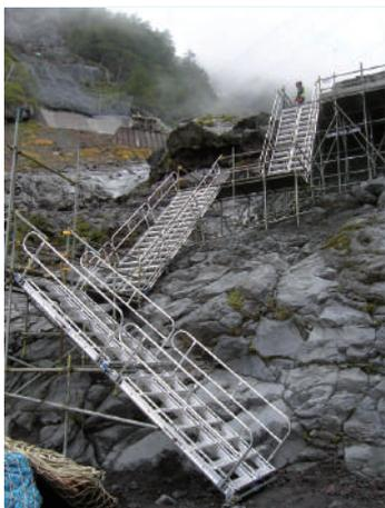
●さまざまな傾斜角度に応じてステップの角度が自在に調整できるアルミ合金製ユニット式階段です。
